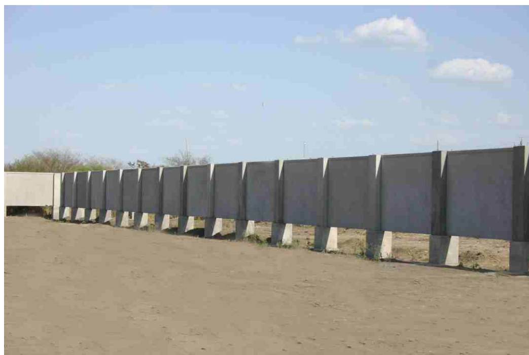
Cimentacion con pilotes.
